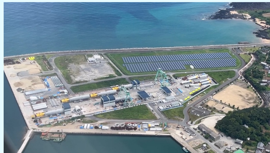
福江港(大津岸壁/大津埠頭)の「岸壁・ヤード」の許容荷重(耐荷重)は約 2 t/m 2 (=約 19.6 kN/m 2 )、面積3ha、風車定格 2MW 長崎五島福江港の整備
