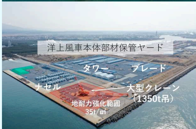
港湾拠点の整備が進む秋田港飯島地区
