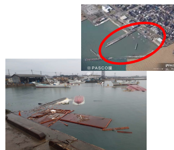
船だまりの被害状況
