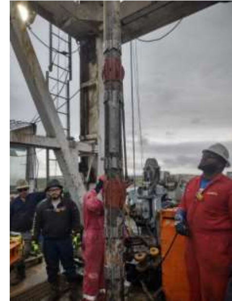
油井への光ファイバセンサケーブル設置作業
