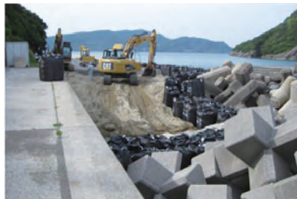
図5 宮崎県串間市における工事風景
